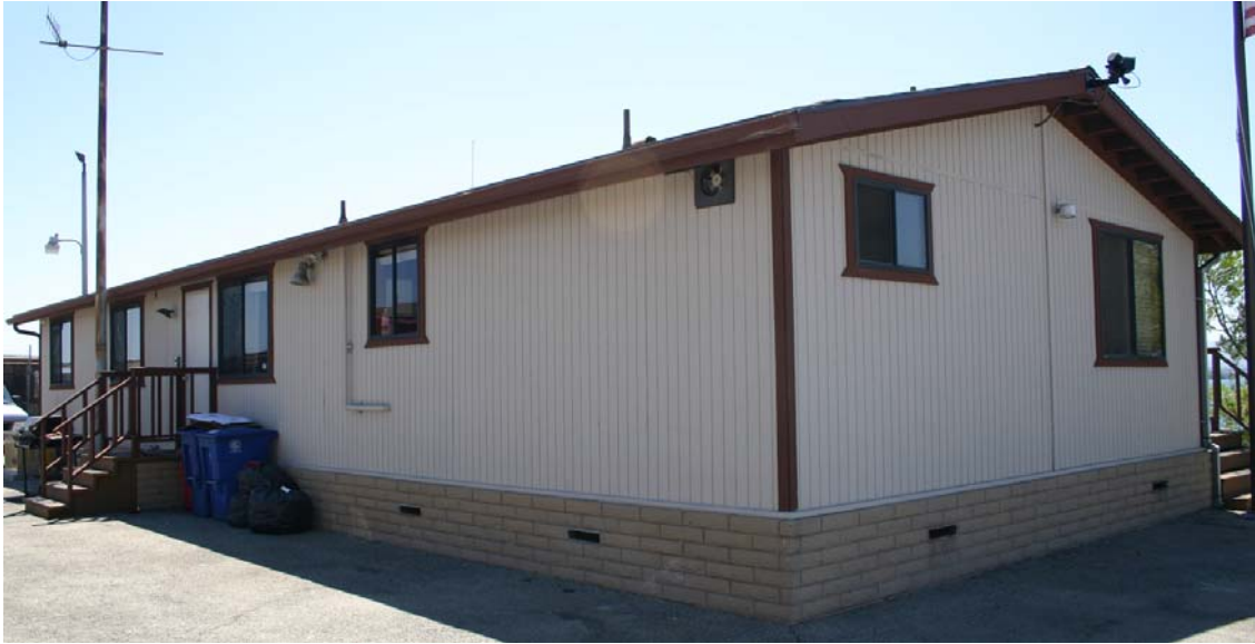
Pier F Berth F202
