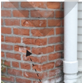
Spalling
