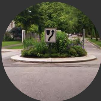
Una mini rotonda es una isla circular elevada en medio de una intersección que tiene tráfico unidireccional [izquierda] circular giratoria de tráfico alrededor de él. El tráfico entrando debe ceder al tráfico ya en la rotonda.
