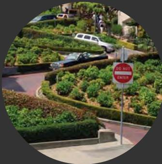
Una chicane es una serie de acera extensiones alternos [o plazas de estacionamientos en la calle] que obliga a conductores retrasar mediante la creación de un camino en forma de S.
